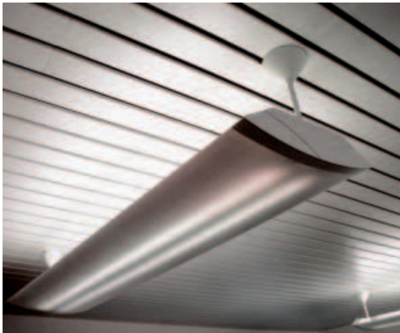
Bild 27 Gute Leuchten für Bildschirmarbeitsplätze: Deckenleuchte, direkt-indirekt strahlend.
