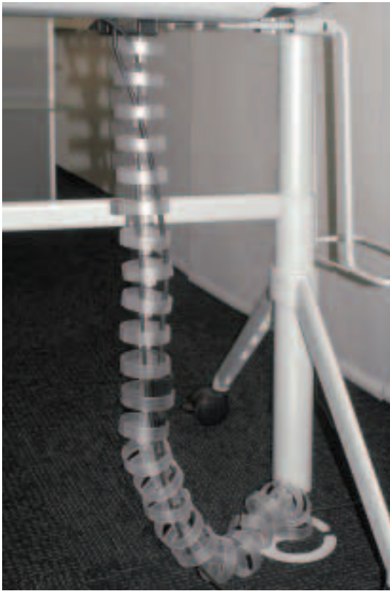
Bild 19 Gebündelte Kabel.
